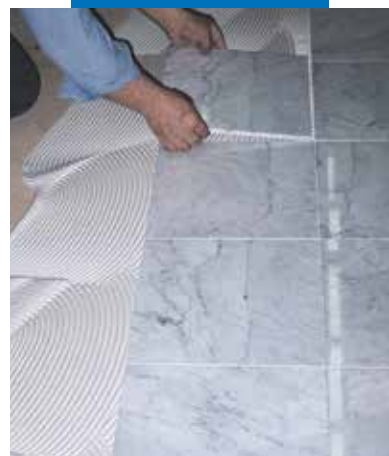
Carrara marmuro kljavimas ant medinio pagrindo su baltu Keralastic
