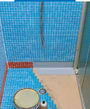
Hidroizoliacijos įrengimas ir plytelių klojimas surenkamajame vonios modulyje
