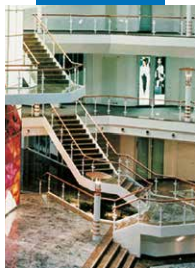
Marmuro ar keramikos montavimo ant metalinų konstrukcijų pavyzdys (laiptai)
