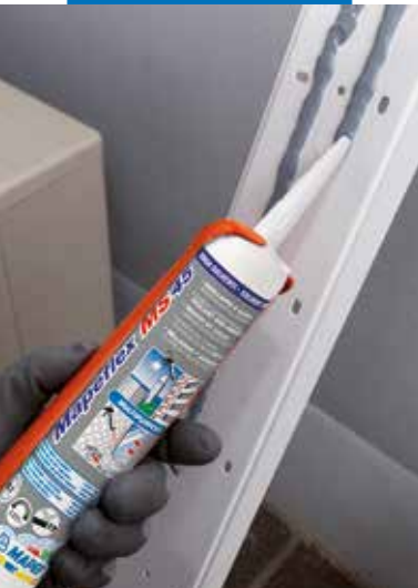
Plastiko profilių klijavimas ant paviršiaus lauke
