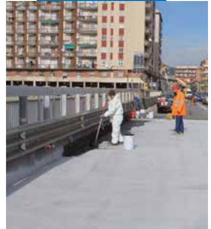
Purtop Primer Black grunto įrengimas
