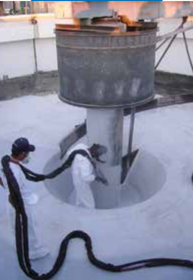
Purtop 1000 hidroizoliacinio sluoksnio įrengimas ant įvairių paviršių
