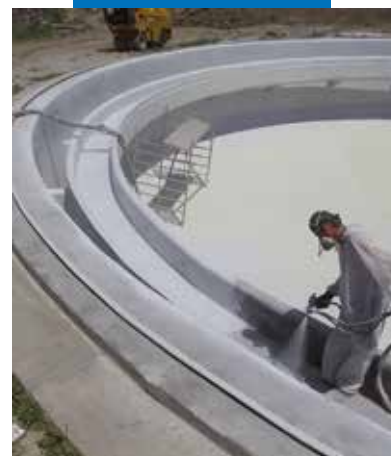
Purtop 1000 hidroizoliacinio sluoksnio įrengimas ant pramoninių talpų paviršių
