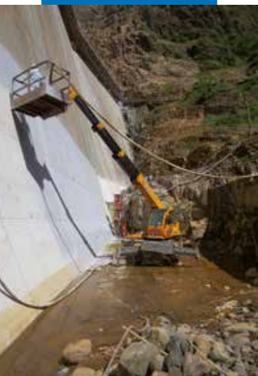
Užtvankos hidroizoliacija
