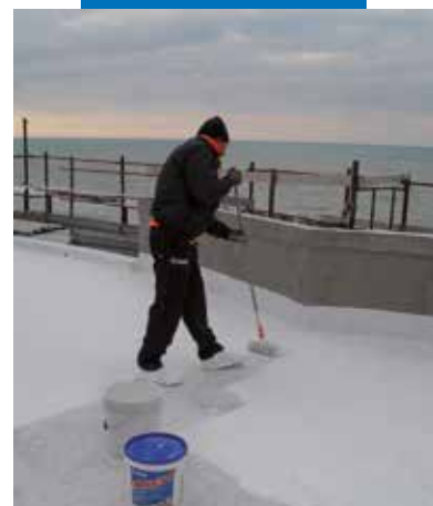
Triblock P sluoksnio įrengimas voleliu ant betoninio pagrindo
