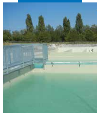
Talpyklos hidroizoliuotos naudojant Purtop 1000
