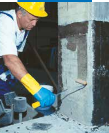
MapeWrap Primer 1 Grunto tepimas
