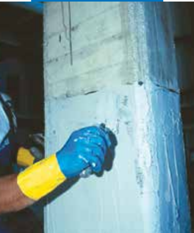
Išlyginimas su MapeWrap 11 arba MapeWrap 12
