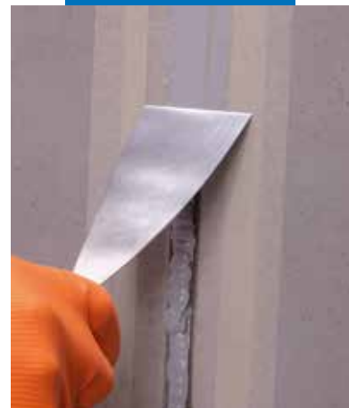
Mapeflex PU40 išlyginimas
