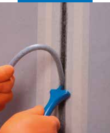
Juostos Mapefoam įrengimas siūlėje
