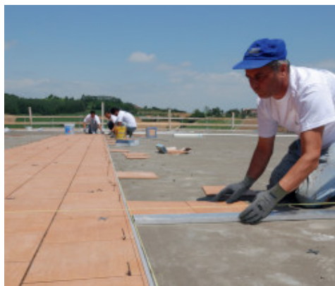
Keraminių plytelių klojimas su Kerabond + Isolastic
