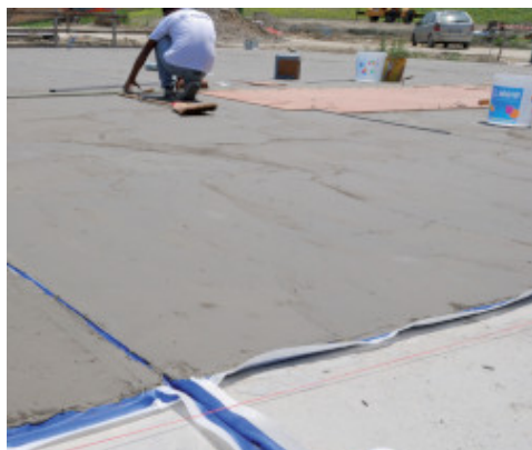
Hidroizoliacinio sluoksnio įrengimas su Mapelastic ir Mapeband
