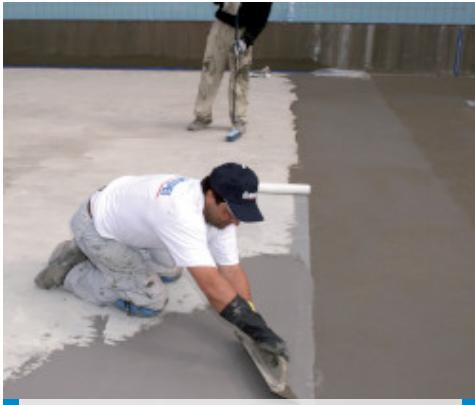
Plaukimo baseino hidroizoliavimas su Mapelastic
