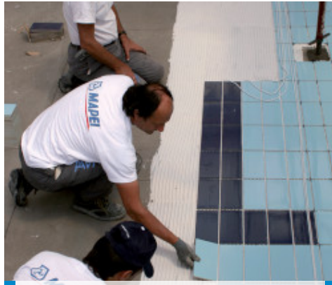
Keraminių plytelių klojimas ant Mapelastic baseine
