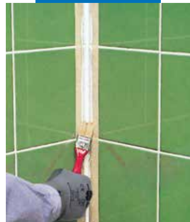
Siūlių lyginimas teptuku, sudrėkintu muiluotame vandenyje
