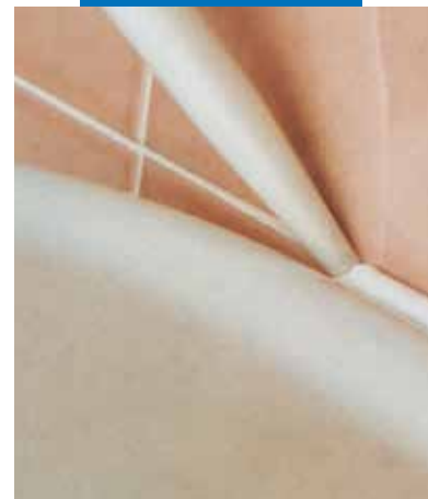
Santechninės įrangos sandinimas
