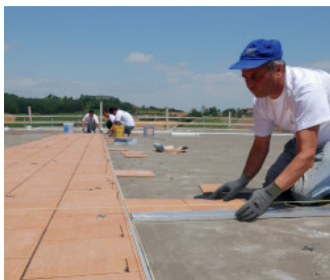
Keraminių plytelių klojimas su Kerabond + Isolastic
