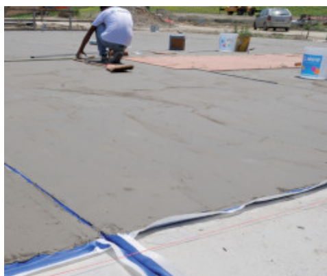
Hidroizoliacinio sluoksnio įrengimas su Mapelastic ir Mapeband
