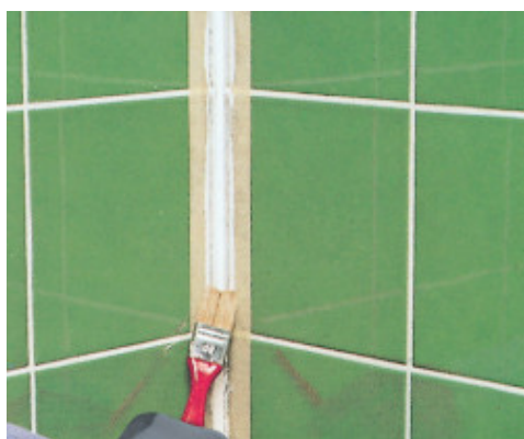
Siūlių lyginimas teptuku, sudrėkintu muiluotame vandenyje
